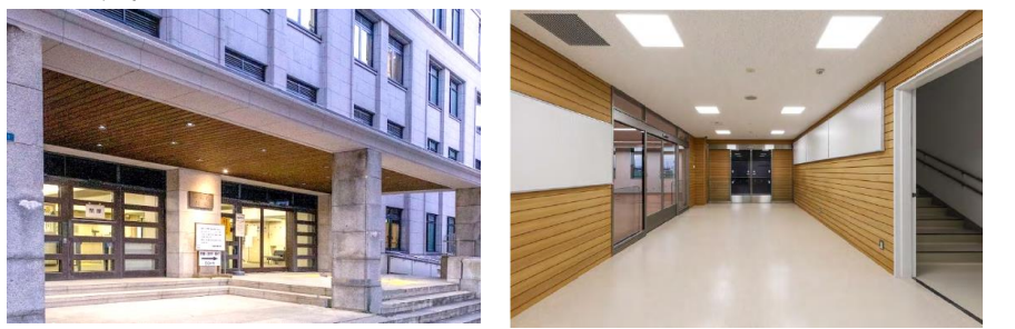
参議院 参議院別館（東京都）〔玄関庇裏〕
