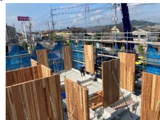
木造事務所建設の様子
